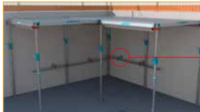
- Mettre en place la stabilisation des premiers éléments. - Une fois la stabilisation en place, il est possible de retirer les trépieds.
