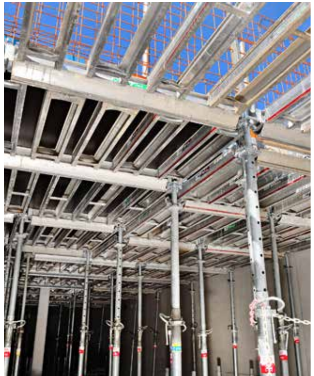
20 000 m 2 de surfaces de dalles
