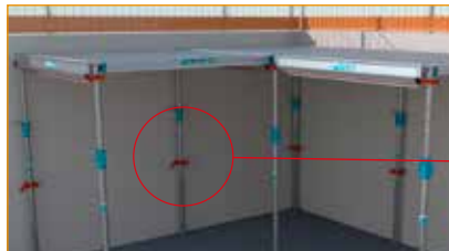
- La mise en place de cette bride peut se faire avant ou après le positionnement de l'étais.
